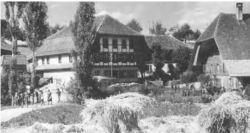
Die Riedbachmühle (mit Gasthaus, Bäckerei und Bauernhaus; alle Gebäude aus der 1. Hälfte des 19. Jahrhunderts)
